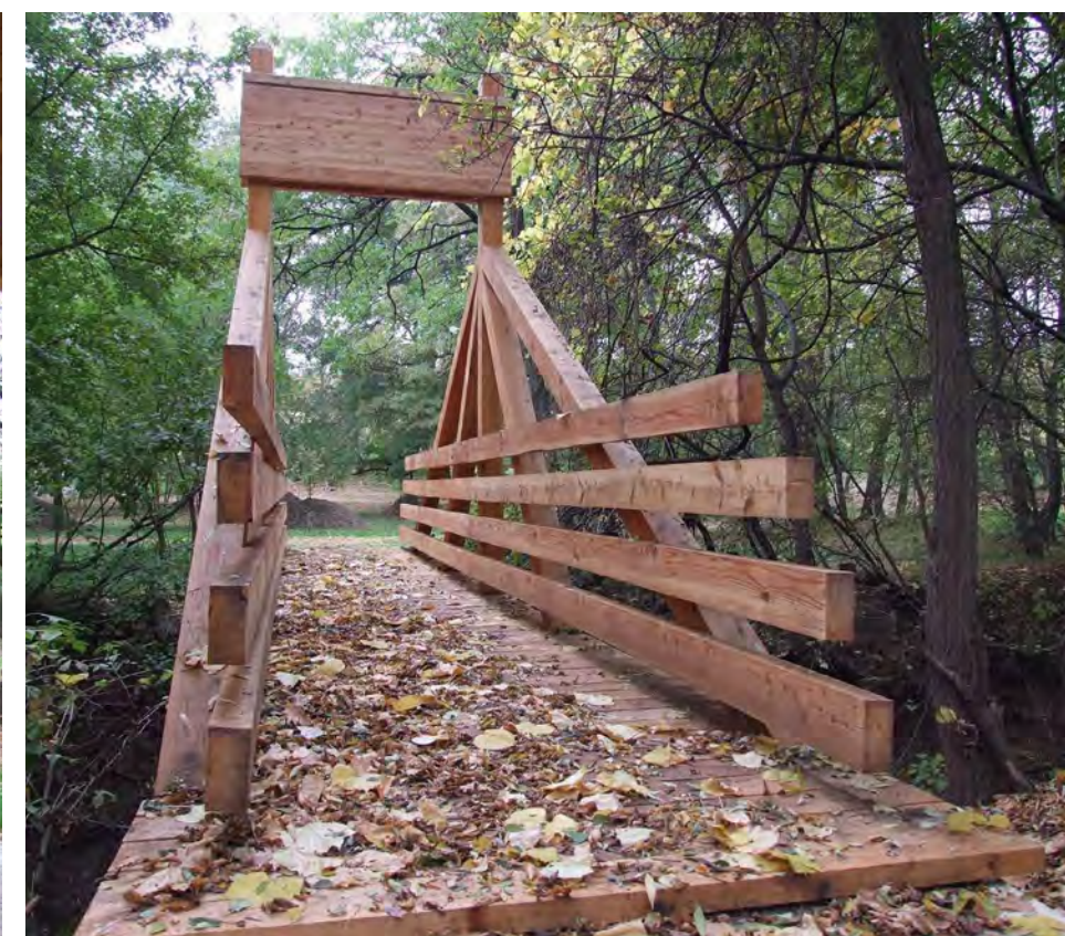
Mád, szilvásfürdő rekonstrukciója, 2006-2008
